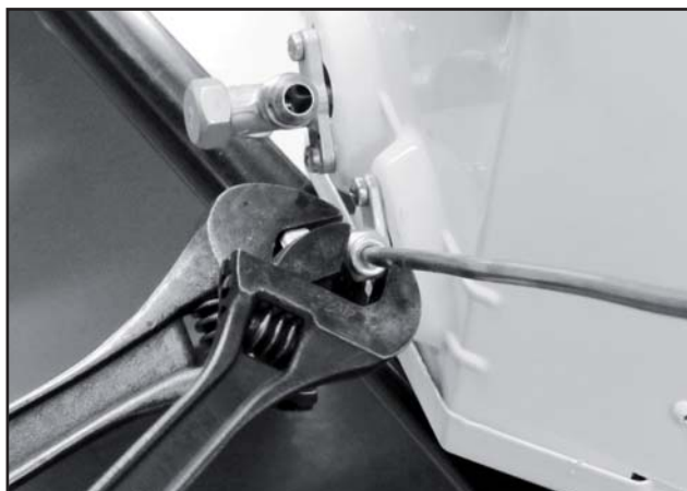
FIGURA 24 - FIXAÇÃO DA PORCA
