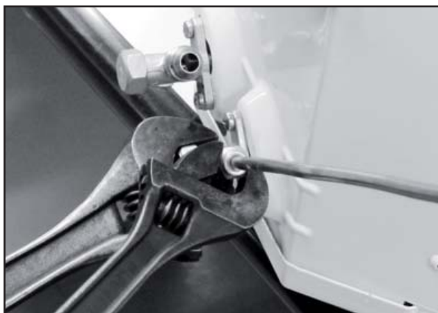
FIGURA 29 - FIXAÇÃO DA PORCA
